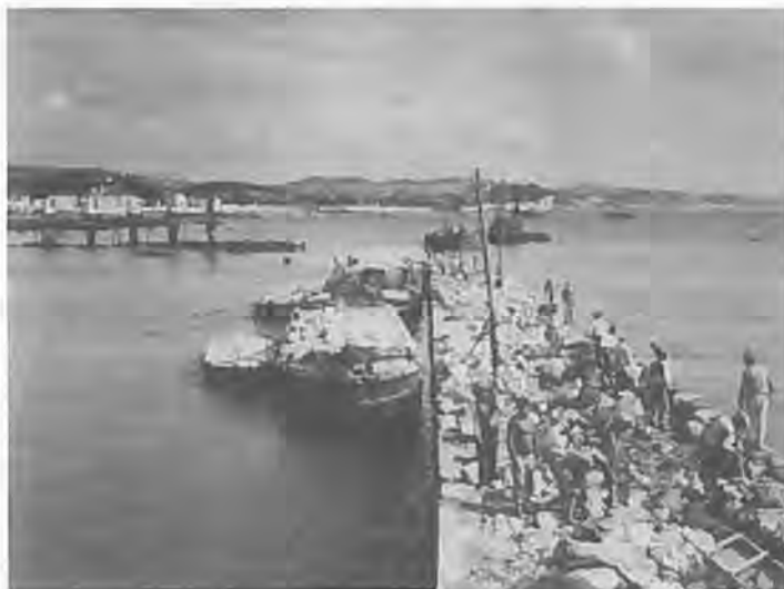
Figura 6 – Obras no Porto de Lisboa
