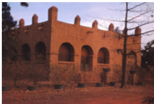
FIG. 5 Edifício do IFAN em Saint Louis, 1956
