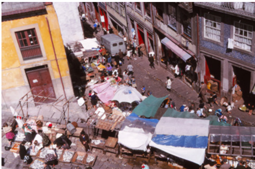
FIG. 5 Vista da Ribeira no Porto, 1965
