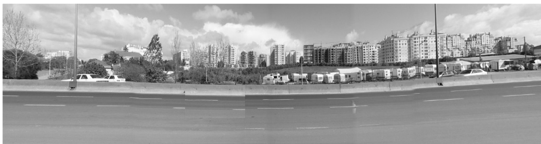
Fig. 4.3 – Vista do norte de Lisboa a partir da Segunda Circular (Av. General Norton de Matos). À esquerda uma paisagem ainda “intocada” no enfiamento do Colégio Militar. À direita a construção do “Parque dos Príncipes”, uma barreira arquitectónica de progressão ao vento de Norte, que “promete” estender-se para leste, até ao Aeroporto de Lisboa (pelo menos até à sua relocação).
